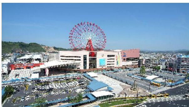
アミュプラザ鹿児島と中央駅東口駅前広場
